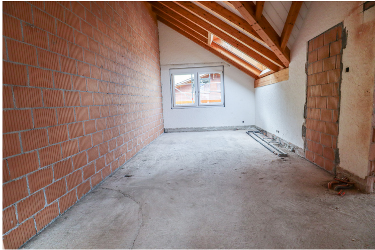
Eingangsbereich & Zimmer 2 (Wand wird noch gezogen)
