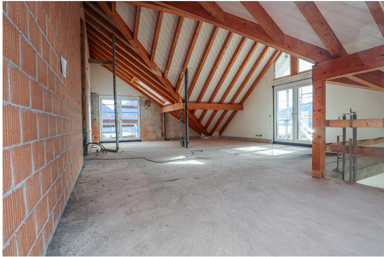
Zimmer 3 (Wand wird noch gezogen) / Wohn- & Essbereich
